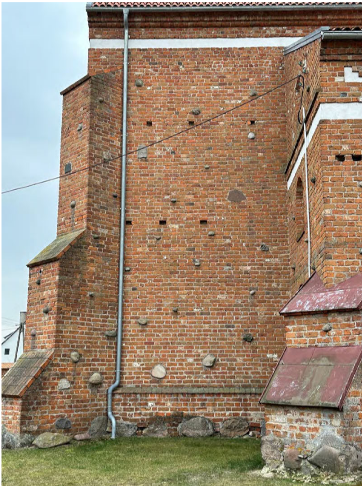
Fot. 37. Fragment elewacji północnej prezbiterium – stan zachowania. Po prawej widoczna zakrystia.
