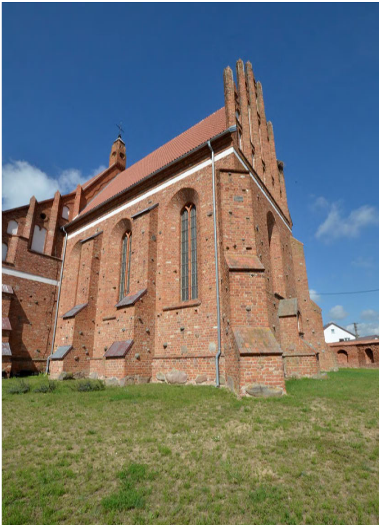
Fot. 27. Prezbiterium od strony południowej. Widoczne różnice opracowania nakryw uskoków szkarp.
