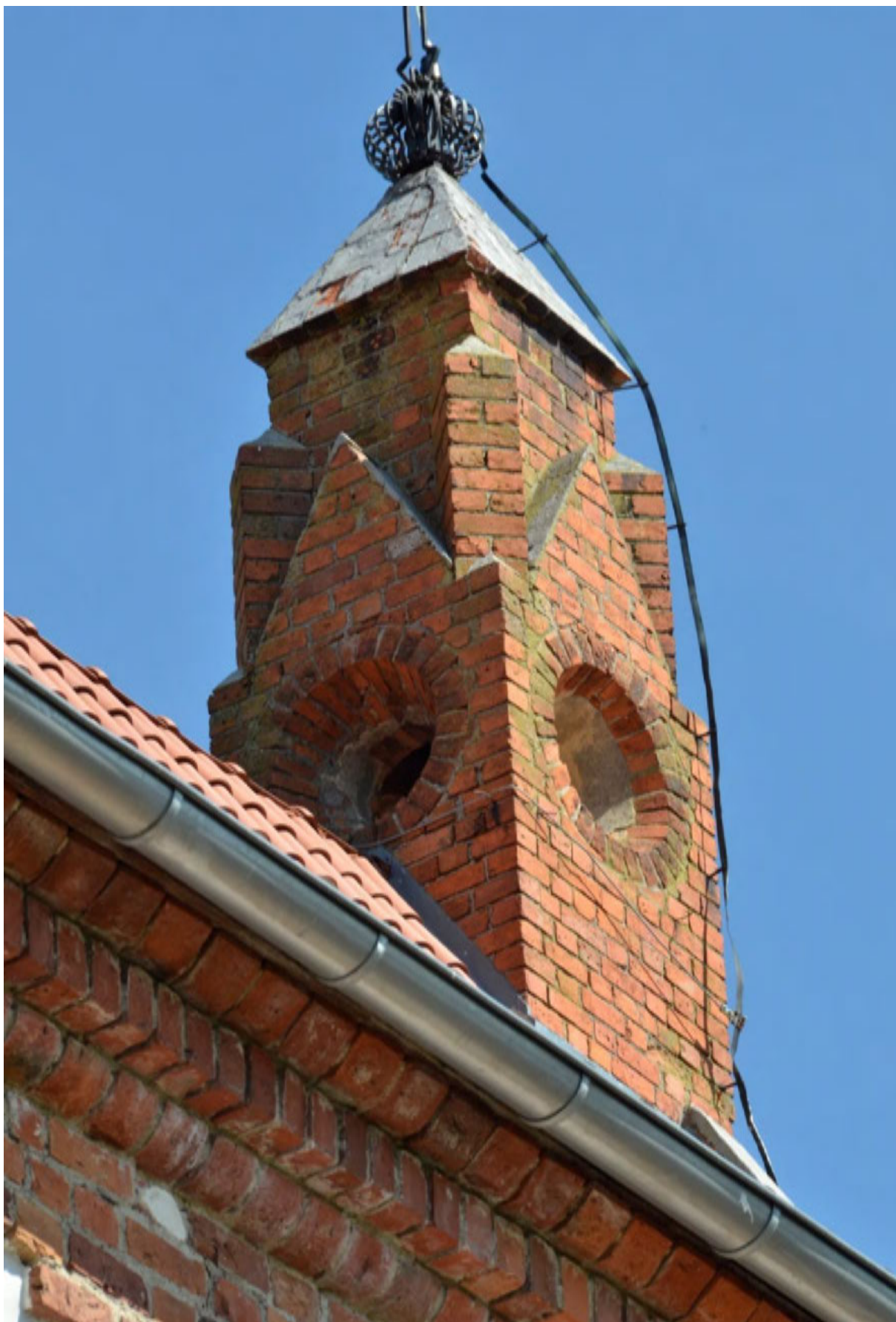
Fot. 57. Sygnaturka – widoczne nawarstwienia biologiczne.
