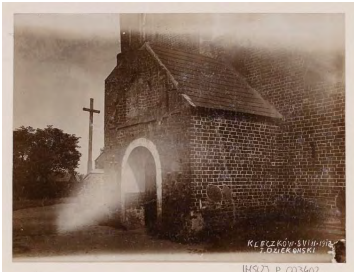
Ilustracja 22. Elewacja zachodnia, ze zbiorów Instytutu Historii Sztuki Uniwersytetu Jagiellońskiego, autor: Józef Pius Dziekoński, 1912, dostęp: http://www.fototeka.ihs.uj.edu.pl
