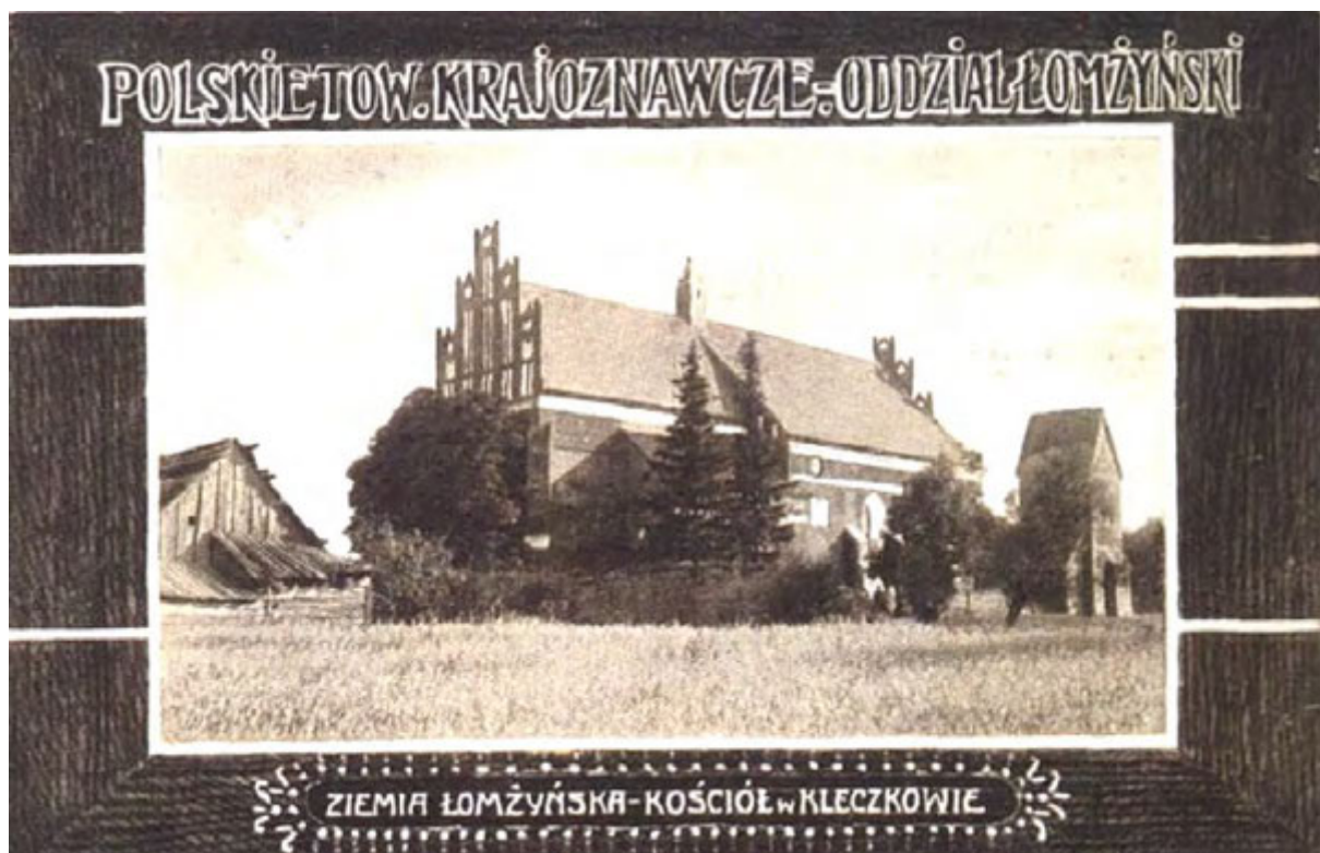
Ilustracja 20. Widok na południowo-zachodnie naroże, [w:] Piękna nasza Polska cała... Pocztówki Polskiego Towarzystwa Krajoznawczego, 1910, dostęp: https://architrend.pl/
