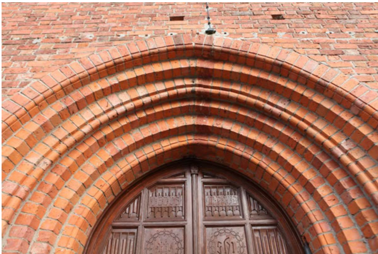
Fot. 5. Detal portalu głównego – profilowanie ukształtowane w cegle.
