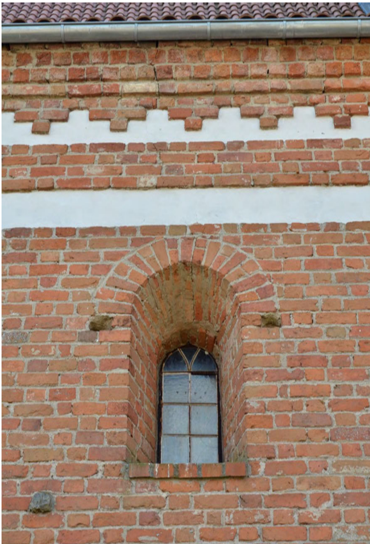
Fot. 47. Fragment elewacji północnej zakrystii – okno pomieszczenia drugiej kondygnacji.
