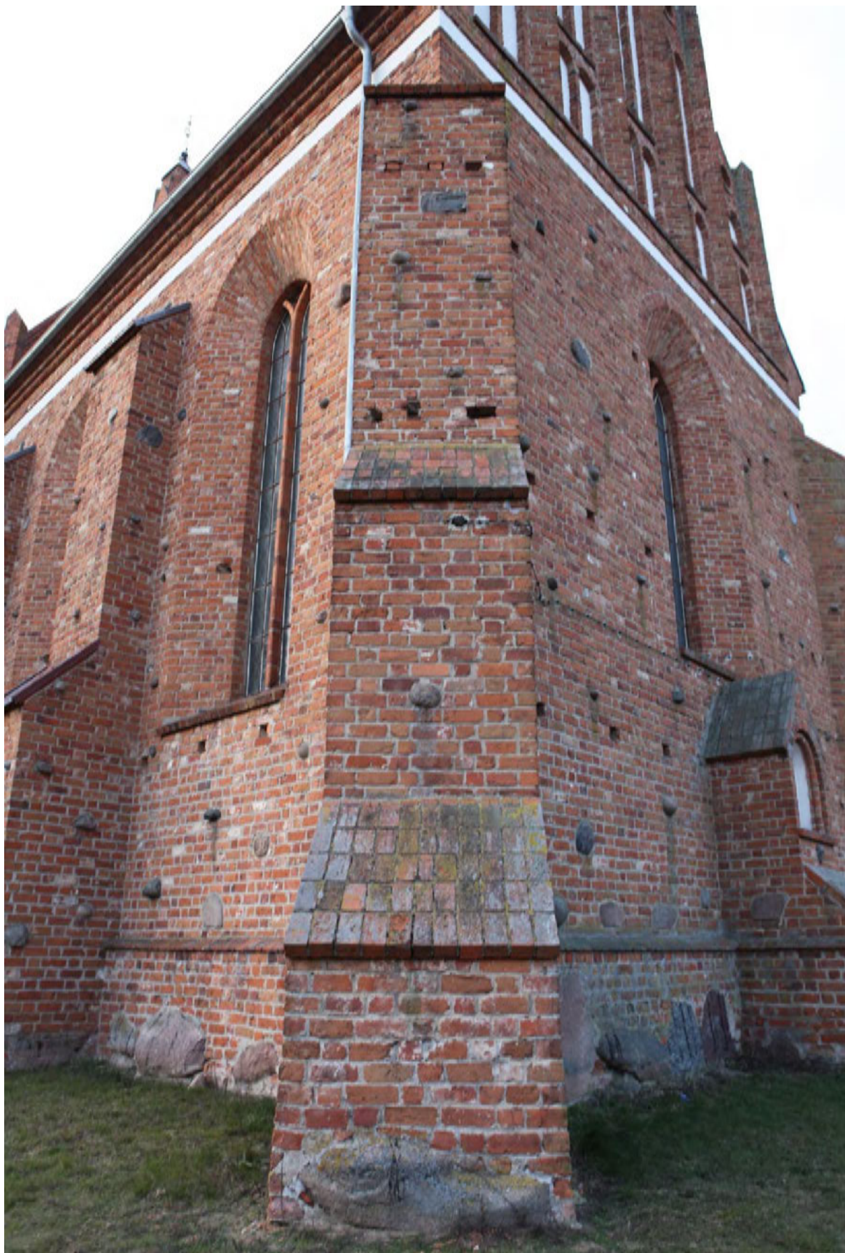
Fot. 28. Narożna przypora prezbiterium – nakrywy z cegły ceramicznej.
