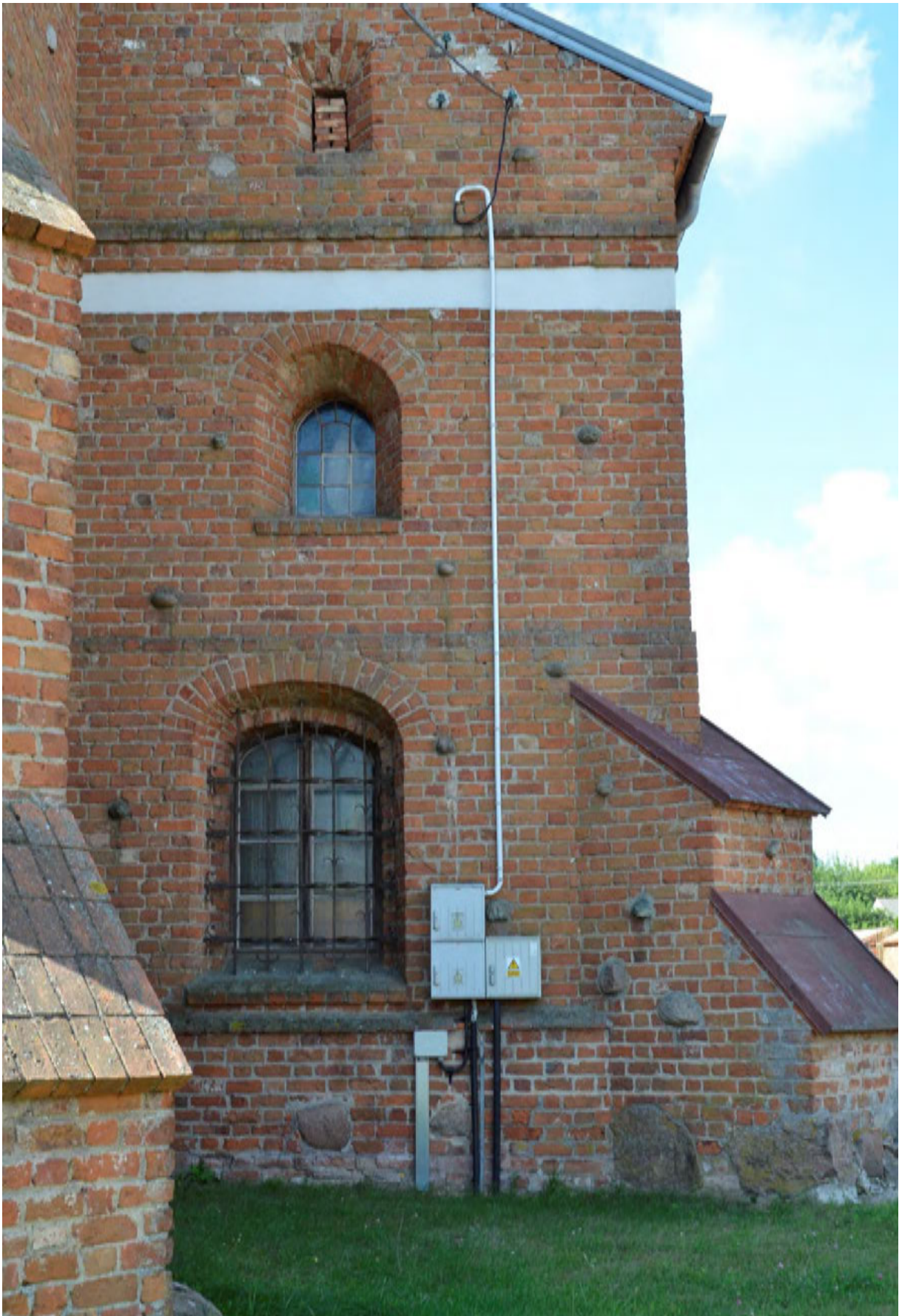
Fot. 40. Elewacja zachodnia zakrystii.
