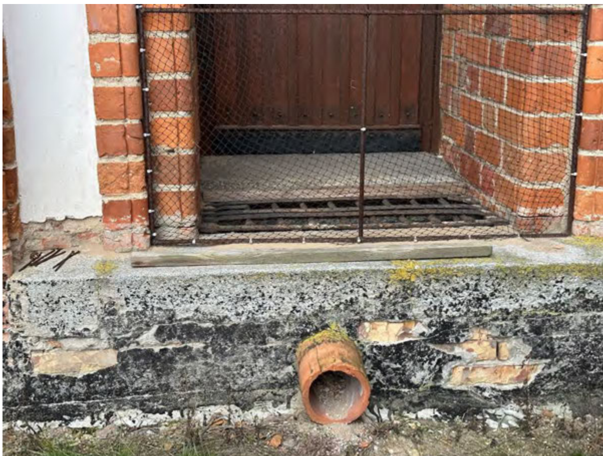
Fot. 23. Wejście do nawy południowej – masywny podest z cegły wyprawiony tynkiem cementowym – konieczna ponowna aranżacja wejścia.
