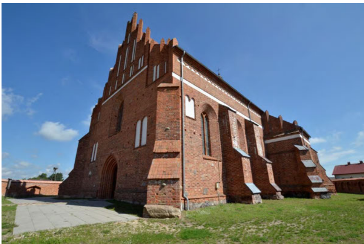
Fot. 2. Widok na elewację frontową i południową.
