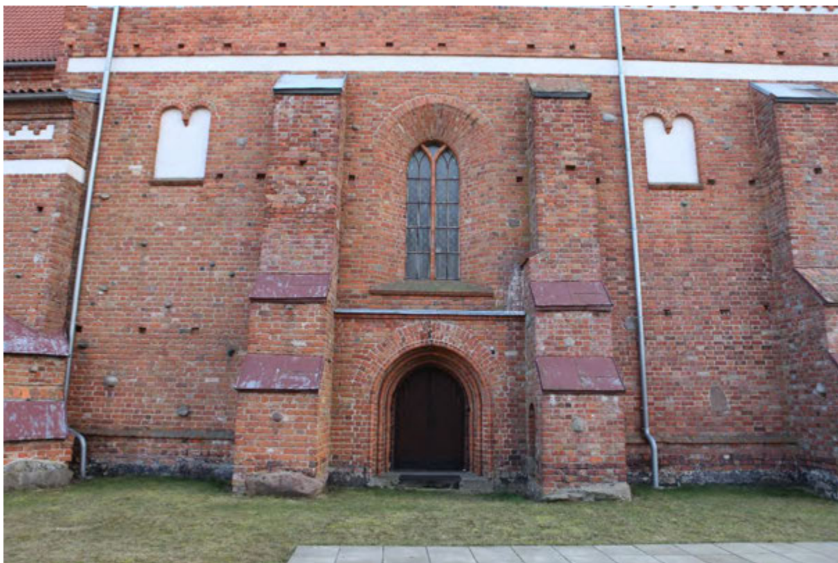
Fot. 51. Wejście do kościoła od strony północnej.
