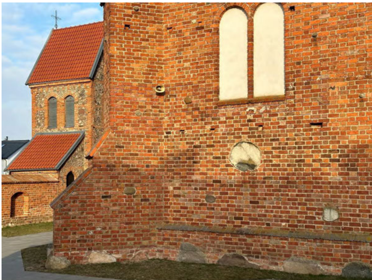
Fot. 6. Północny fragment elewacji frontowej – widoczne liczne głązy wmurowane w mury.
