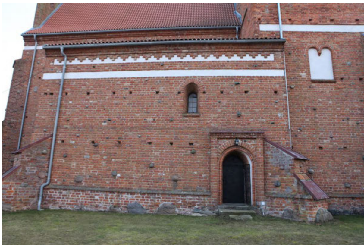
Fot. 39. Elewacja północna zakrystii.
