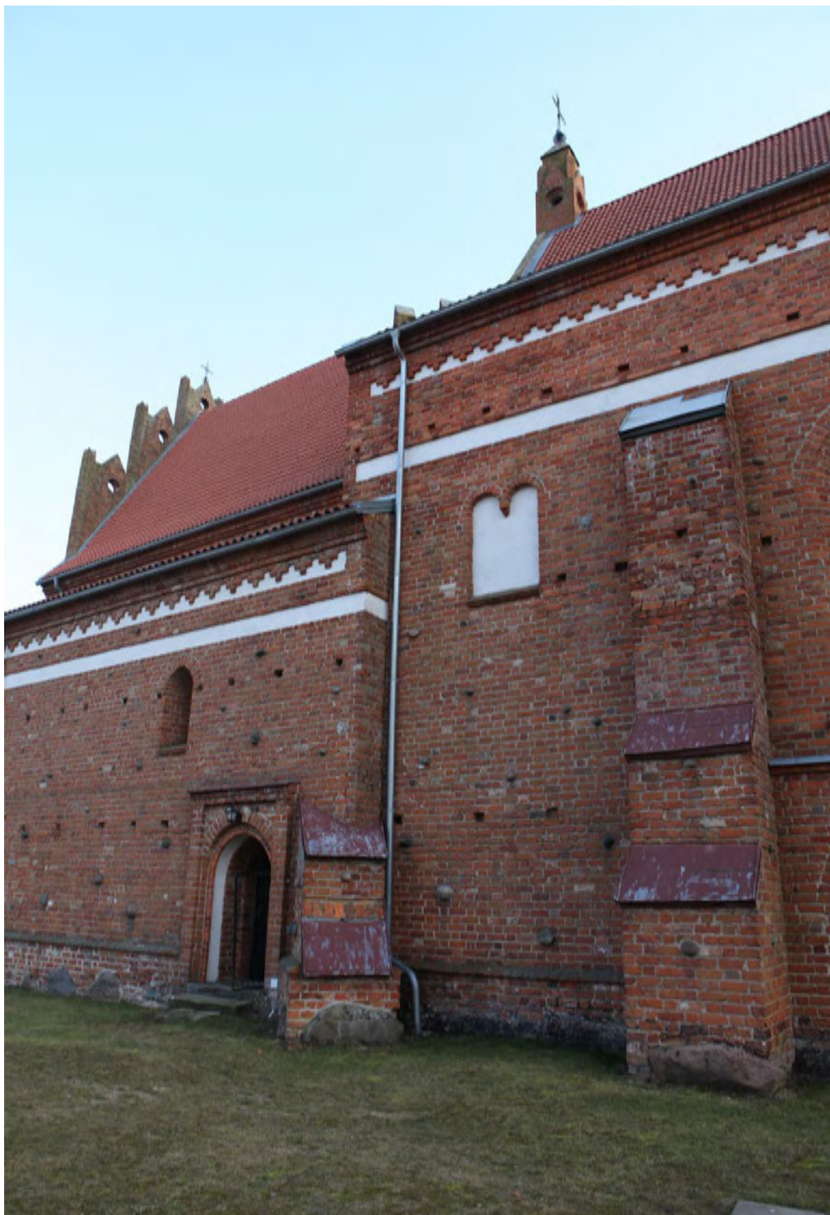
Fot. 48. Widok na elewację północną w kierunku prezbiterium.
