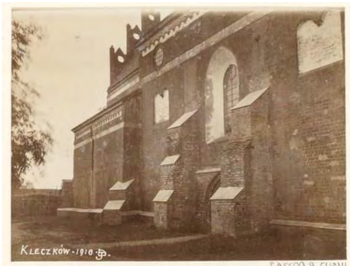
Ilustracja 16. Elewacja północna, ze zbiorów Instytutu Historii Sztuki Uniwersytetu Jagiellońskiego, autor: Józef Pius Dziekoński, 1910, dostęp: http://www.fototeka.ihs.uj.edu.pl
