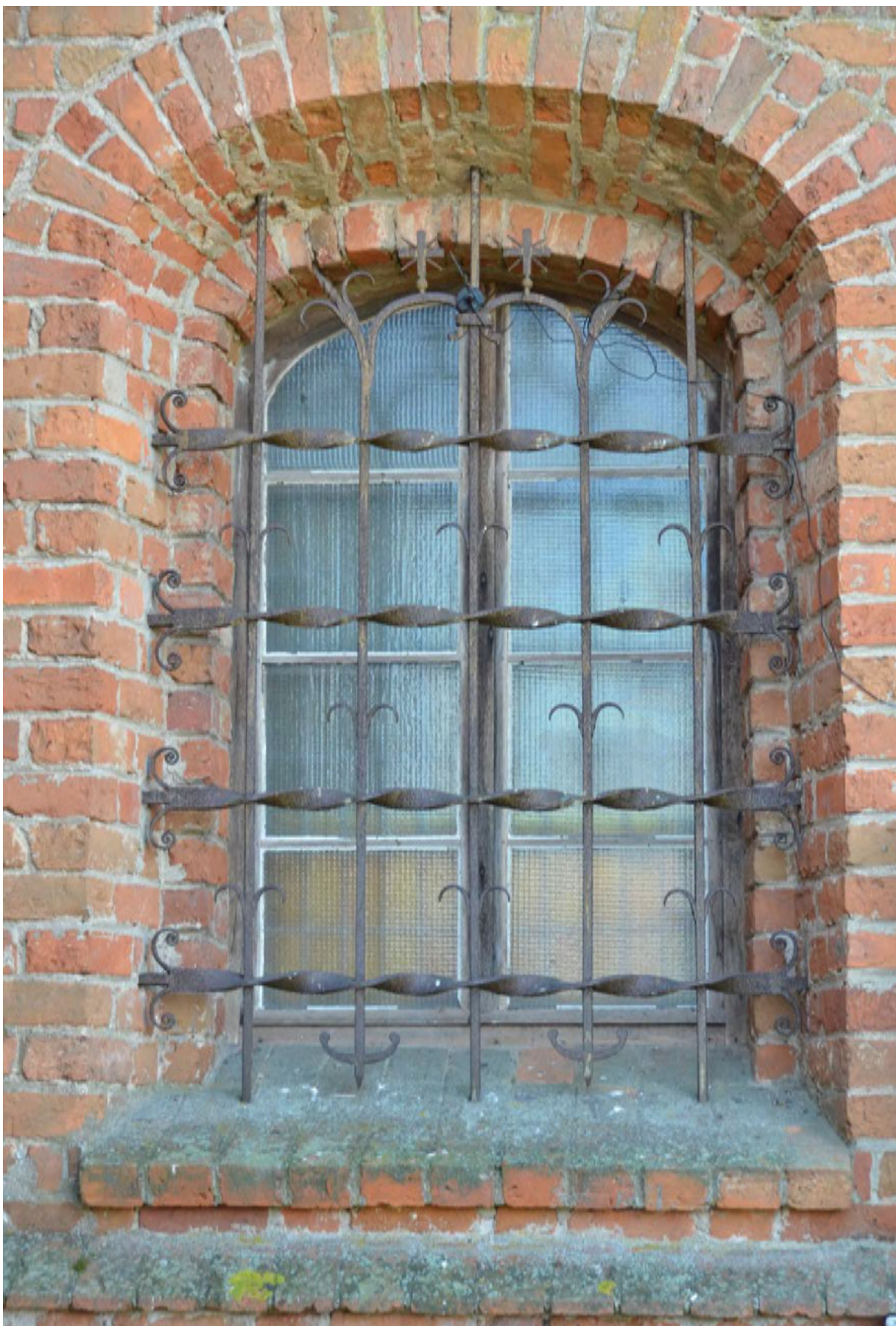
Fot. 46. Okno w elewacji wschodniej zakrystii – ozdobna krata.
