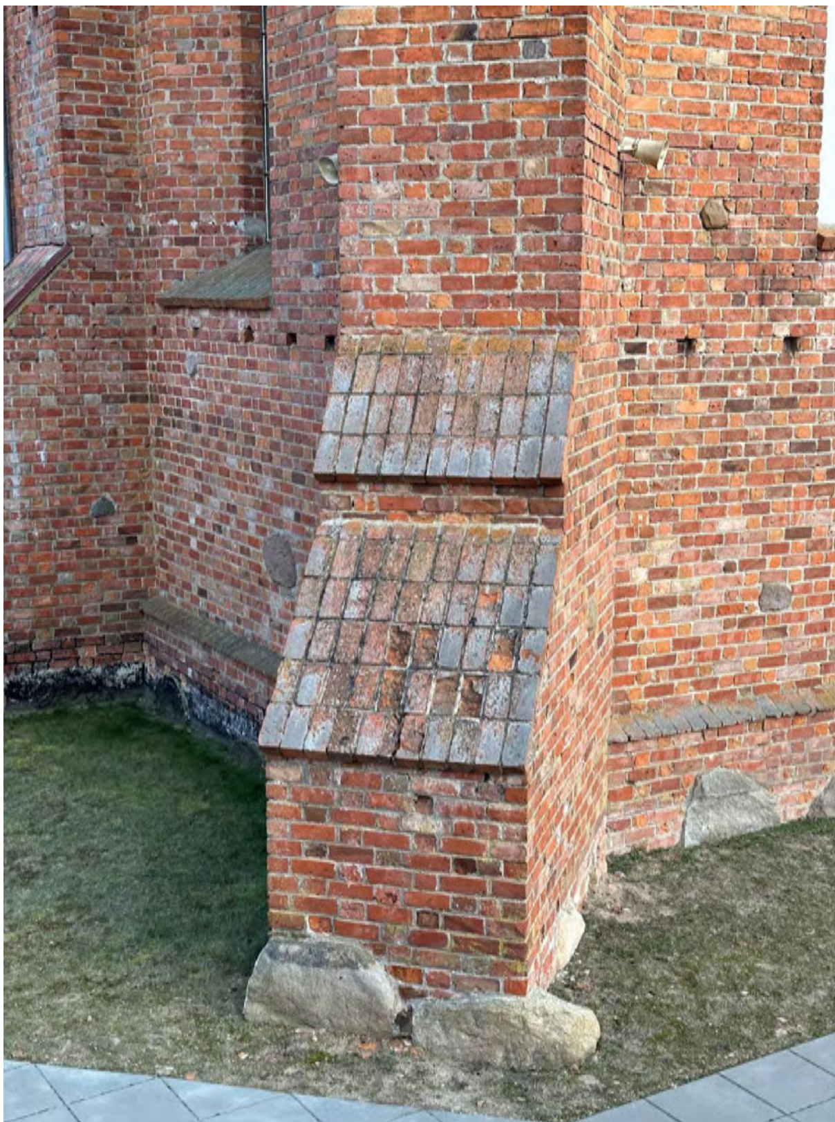
Fot. 56. Ceglane nakrywy szkarp od strony fasady kościoła.
