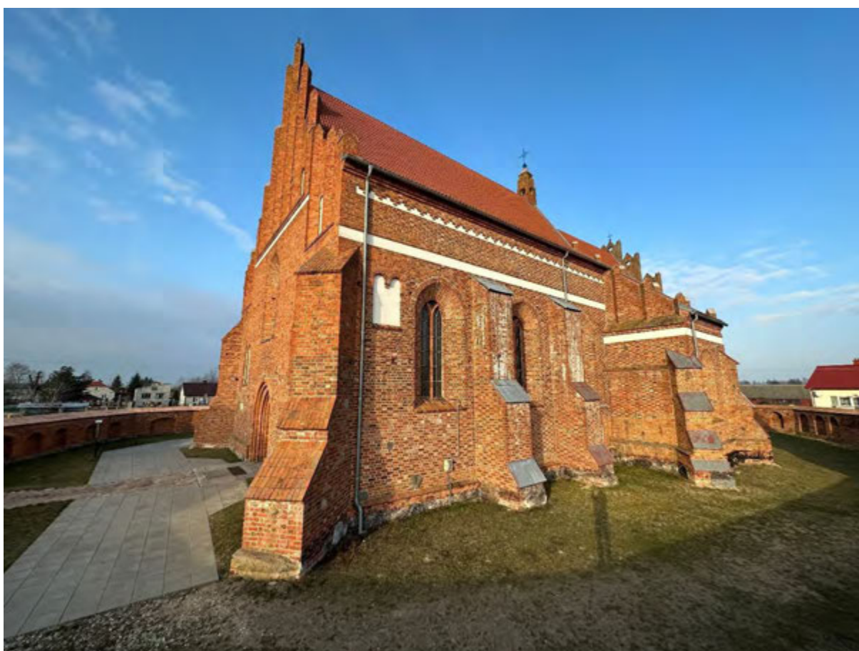
Fot. 13. Widok ogólny na elewację południową.
