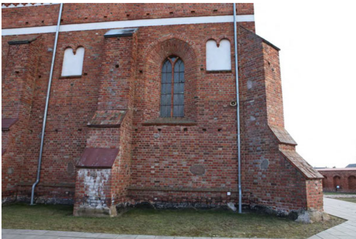
Fot. 52. Zachodnia część elewacji północnej.
