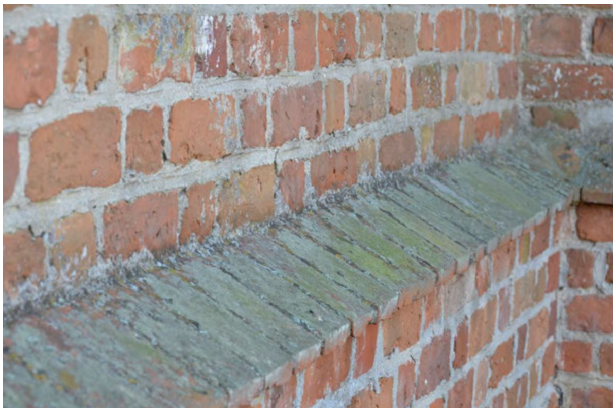
Fot. 41. Zwieńczenie cokołu w obrębie zakrystii – kształtka ceramiczna.
