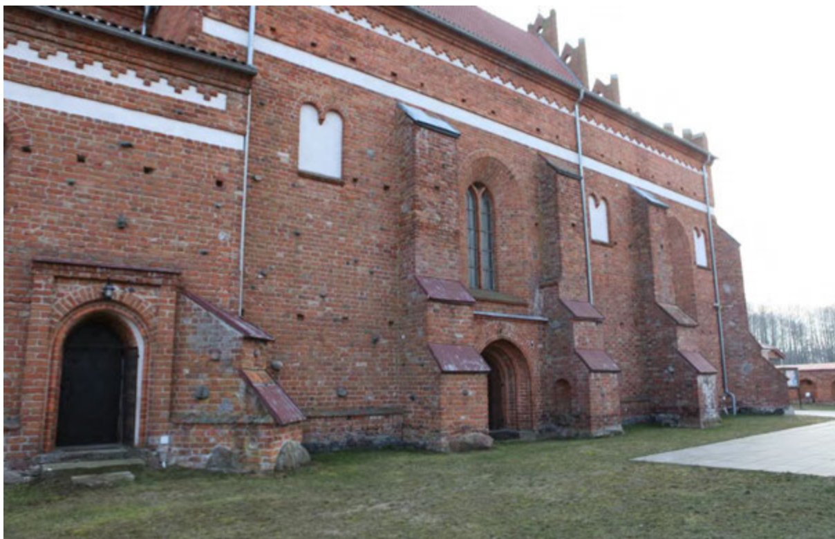
Fot. 49. Elewacja północna – widok w kierunku zachodnim (fasady kościoła).
