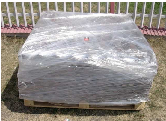
Zdjęcie nr 6. Prawidłowo przygotowane do transportu zdemontowane płyty azbestowo-cementowe.
