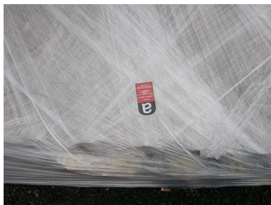
Zdjęcie nr 6. Prawidłowo przygotowane do transportu zdemontowane płyty azbestowo-cementowe.
